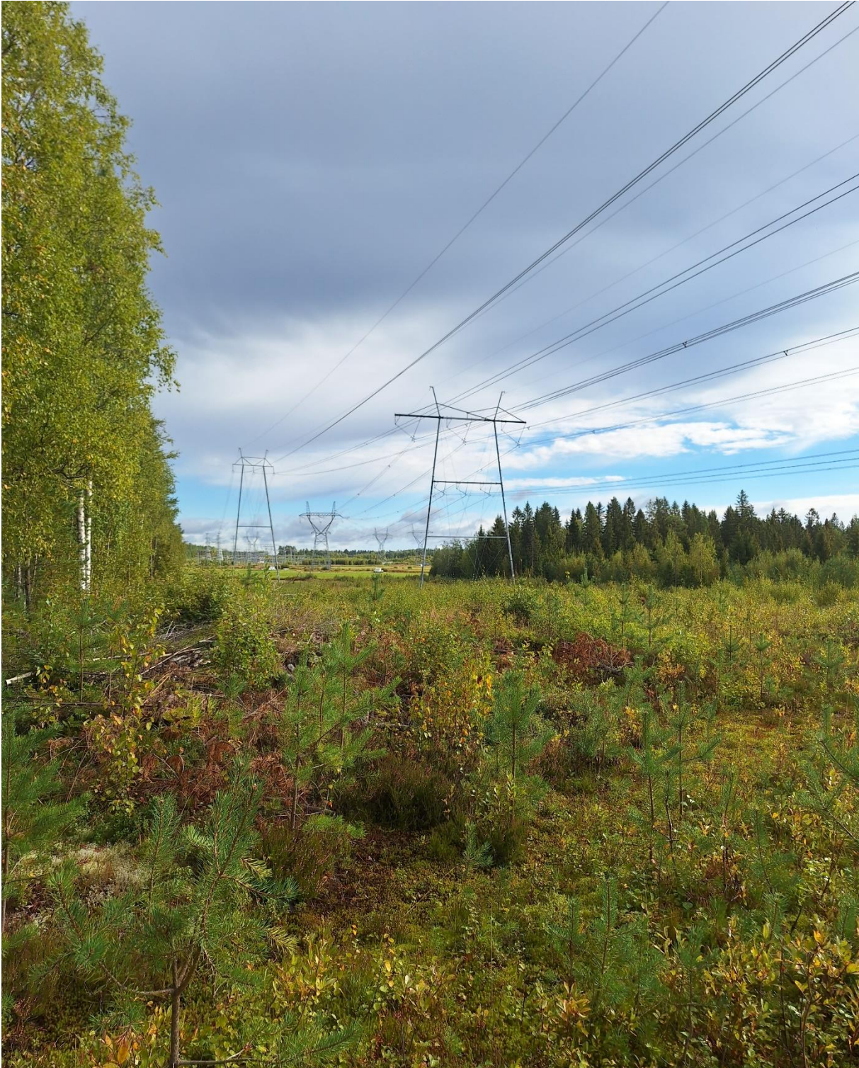
Kuva 18. Voimalinjat erottuvat selvästi maisemassa.
