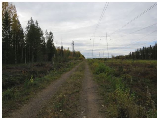
11. Johtoreitti SVE1 päättyy Fingridin linjaan, länteen.
